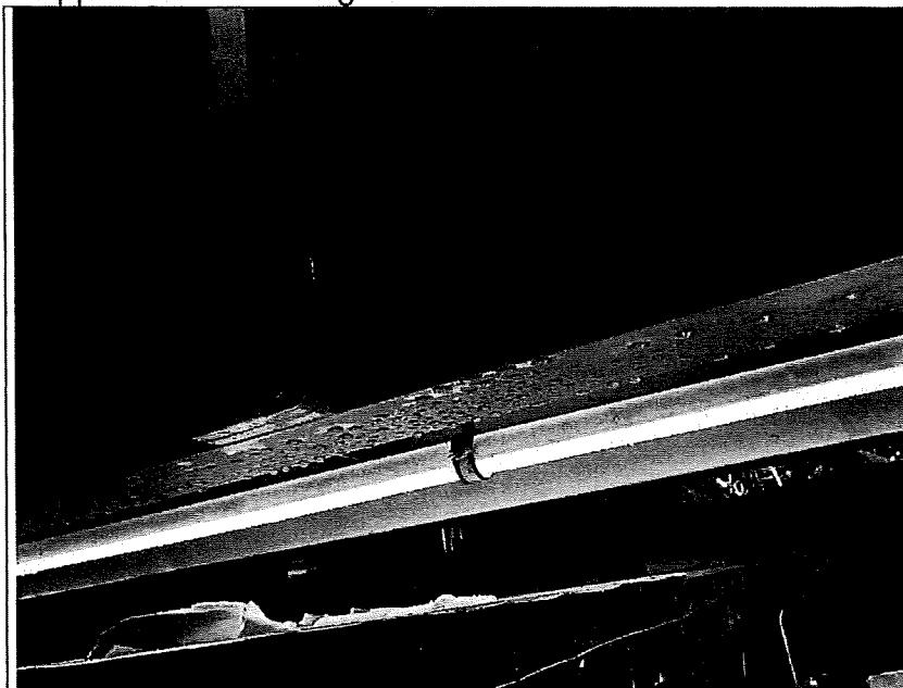
1. Condens op RVS-plaatwerk boven naakt vlees
